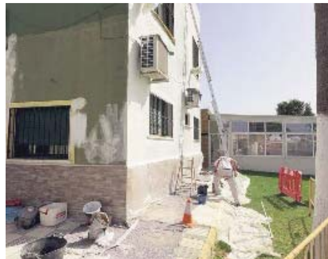
Trabajos en la Delegación de Deportes de Bormujos. AYTO BORMUJOS
