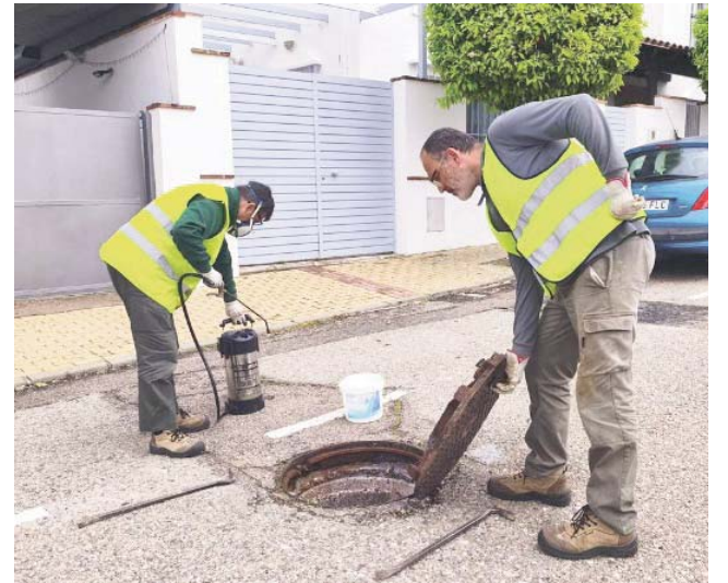
Tratamiento de desratización en la red de saneamiento. AYTO BORMUJOS
