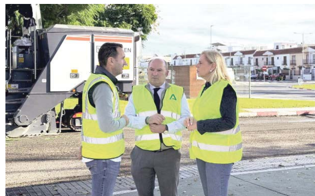
Lola Romero supervisa unas obras. AYUNTAMIENTO DE BORMUJOS
