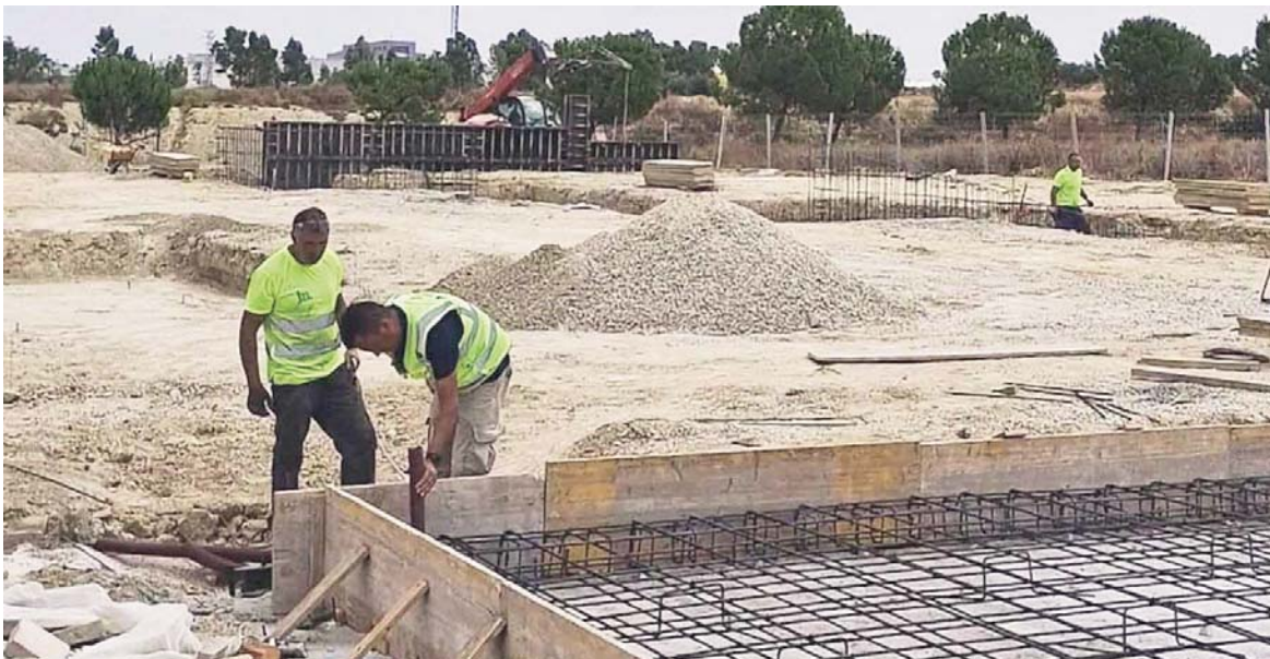
Obras del punto limpio de Bormujos. AYUNTAMIENTO DE BORMUJOS
