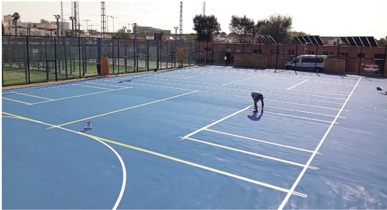
Imagen de la pista multideporte del Polideportivo. AYTO BORMUJOS
