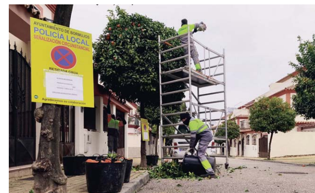
Operarios de mantenimiento de Bormujos. AYTO BORMUJOS
