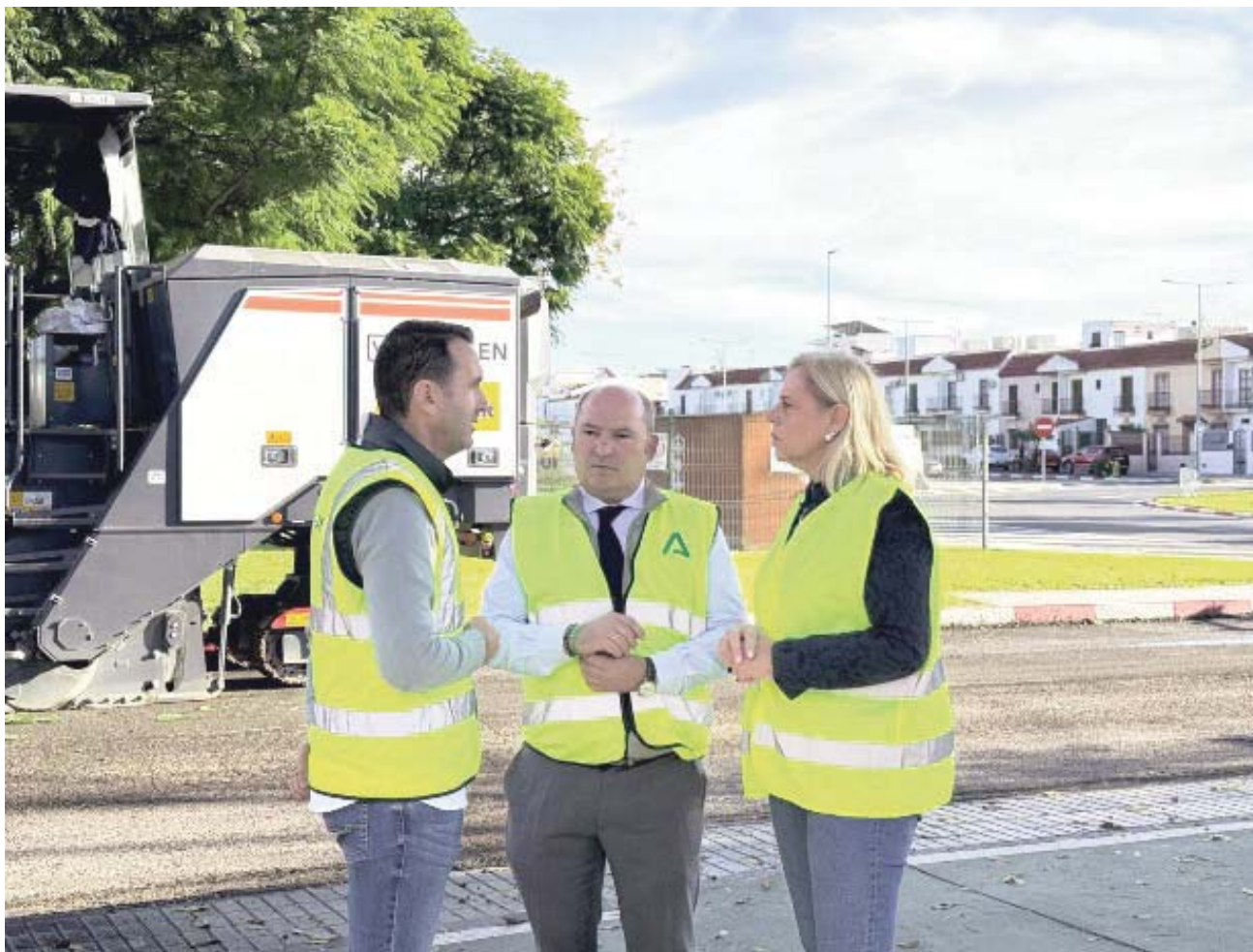
Visita a los trabajos que se están llevando a cabo.
