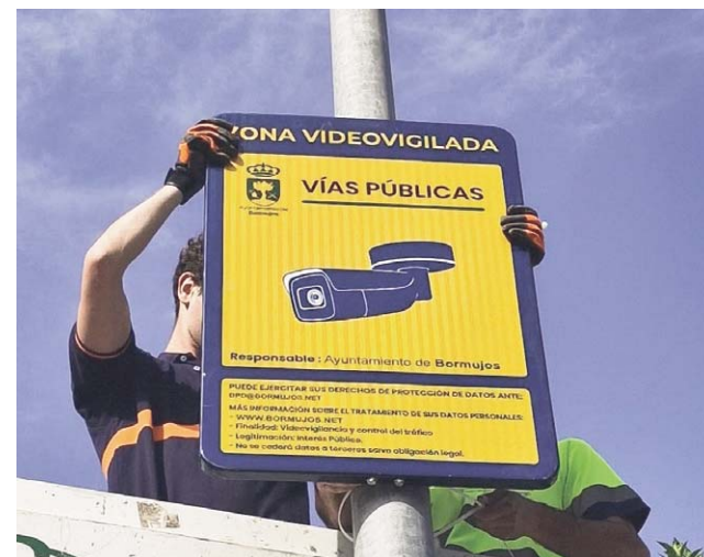
Instalación de las cámaras de videovigilancia. AYTO BORMUJOS
